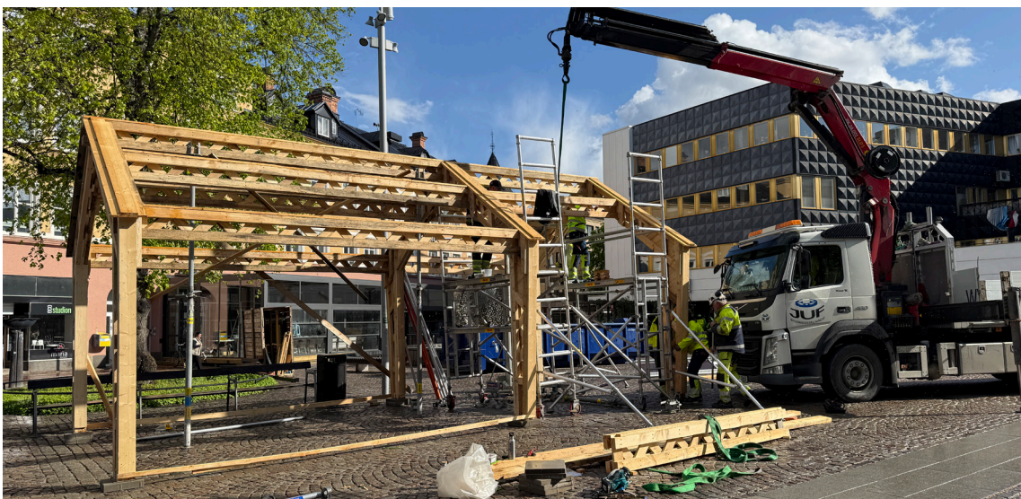
Montering och resning av av paviljongen på Sveatorget. Foto: Gaia ark
